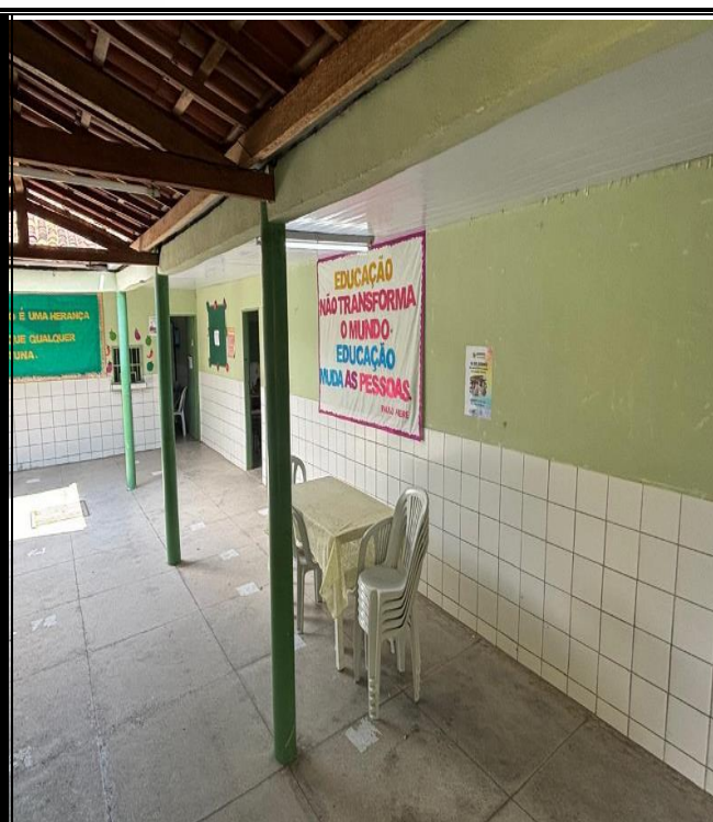
Foto 14: SITUAÇÃO ATUAL DA PINTURA DAS PAREDES INTERNAS E EXTERNAS.
